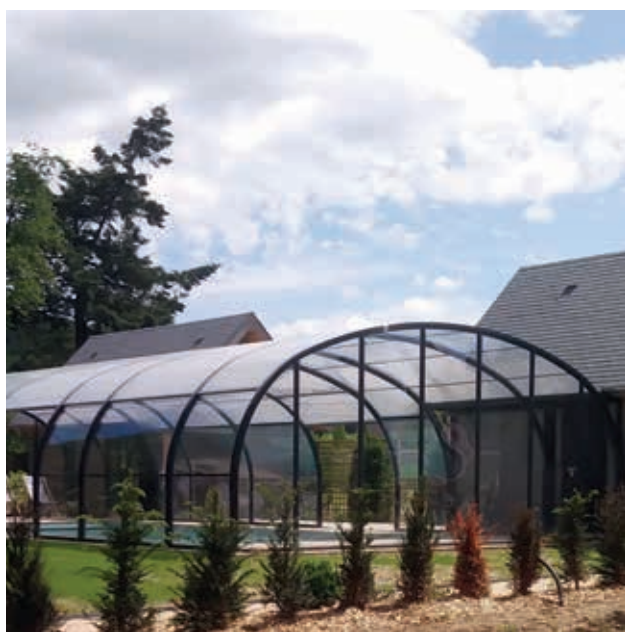
Les matériaux utilisés pour cet abri haut fixe sont le polycarbonate transparent traité anti-UV sur les deux faces pour les parois latérales et le polycarbonate alvéolaire pour la toiture. EuroPiscine
